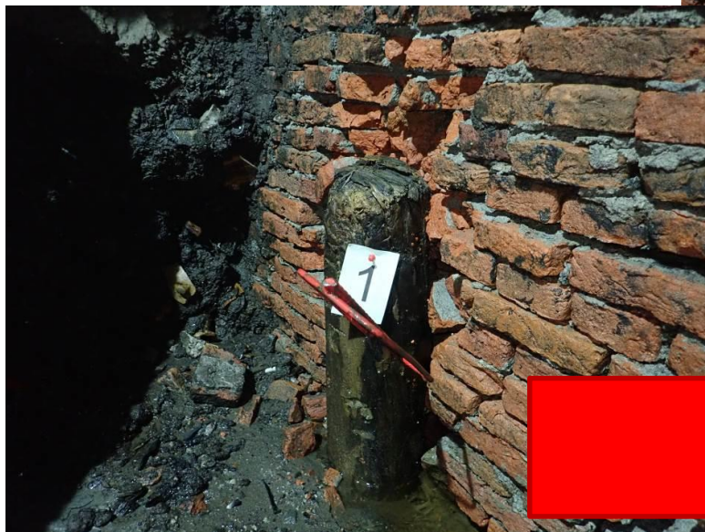
Paal naast de muur . Metselwerk verdwenen/los.
